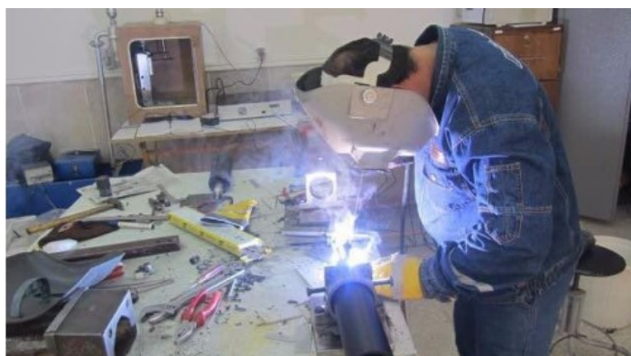
شکل ۱۱ عملیات نصب لوله جهت تنش گیری اولتراسونیک
